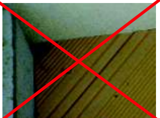
Pustite 5 mm razmak med letvami Forexia® po širini in 15 mm razmak med koncem desk in zidom.
